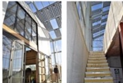
De bovenkant van de serre is gemaakt uit gelaagd glas. Op het dak liggen ook zonnepanelen.
