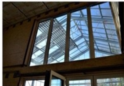
Binnen in de serre staat een houtskeletbouw woning.
